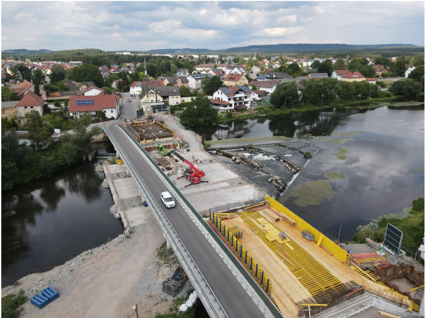
Foto: HABAU Hoch- und Tiefbaugesellschaft m.b.H.
